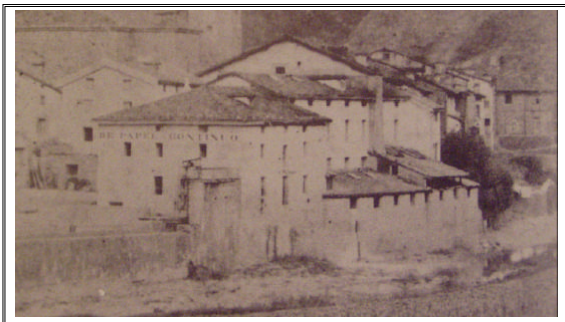
Vista de las instalaciones de La Providencia, en Alegia Tuduri, J. M. º : Argazkiak. Tolosa - Fotografías (1842-1900) , (Donostia-San Sebastián, 1992) p. 52
