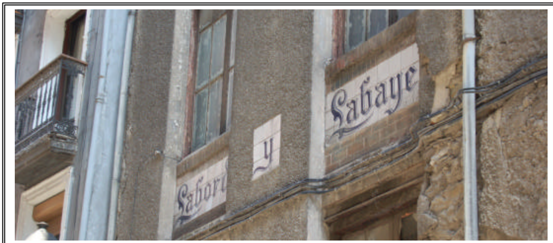
Detalle del rótulo cerámico en la fachada del inmueble
